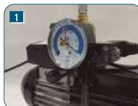
COLLEGAMENTO CON POMPA PER VUOTO
